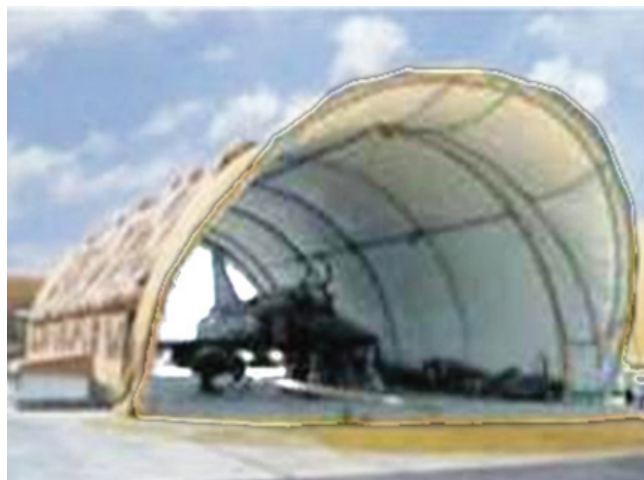
एस यू 30 एम के आई के लिए हर मौसम के अनुकूल पोर्टेबल अनुरक्षण शेल्टर
